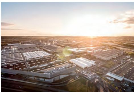
**Grüner Strom direkt vom Dach der Factory 56:** 12.000 PV-Module erzeugen 5.000 MWh Strom, die direkt genutzt, zwischengespeichert oder ins öffentliche Netz eingespeist werden.
